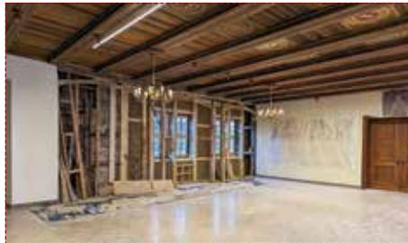
Die Innenansicht der bereits sanierten Fachwerkwand der Westseite des Saales. Alle geschädigten Hölzer der Fachwerkwand wurden getauscht, die Fachwerfelder neu ausgemauert und auf der Wandinnenseite eine zusätzliche Schicht Lehmmauerwerk zur Verbesserung der Wärmedämmung eingebaut.
