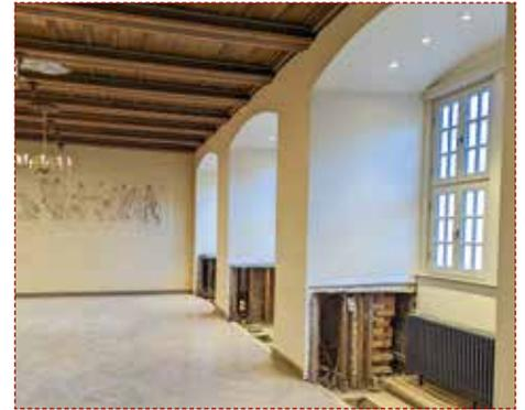
Hier zu sehen: die Freilegung einzelner Gebäudeteile wie Fußbodenaufbau, Deckenbalken und Wandflächen im Rahmen der Bestandsaufnahme in Vorbereitung der Planung der Sanierungen.
