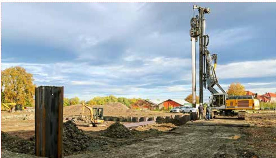
Unmittelbar nach dem offiziellen Startschuss für die Baumaßnahmen wurde mit dem Einlassen der Spundwände zum Bau des Werkstatt-Fundaments begonnen. (Foto: HSB/Dirk Bahnsen)
