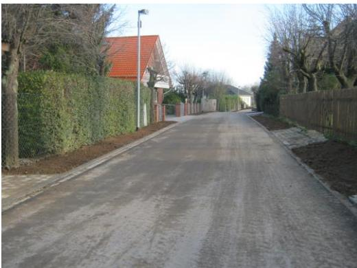
In der Ortslage Benzingerode erfolgte der Grundhafte Ausbau der Fahrbahn und der Nebenanlagen. Im gesamten Ausbaubereich war der Verkehrsraum unbefestigt.
