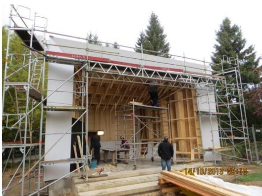
Die durch den Brand im April 2012 zerstörten Bereiche wurden fachgerecht wieder aufgebaut. Nach Beseitigung der brandgeschädigten Bauteile erfolgte die Neuverlegung der im Filterraum erforderlichen Grundleitungen
