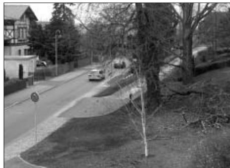
Hier wurden Betonbaustellenplatten, die als Wegebefestigung dienten, entfernt und durch Natursteinplatten und Natursteinpflasterung ersetzt. Die ebenen Natursteinplatten bilden die Zufahrtsfläche für Rollstuhlfahrer und Kinderwagen zum Lustgarten.
