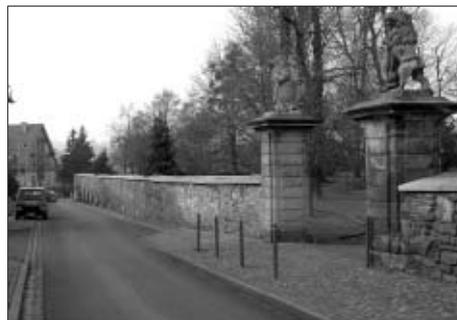
Ein großer Teil der Mauer um den Lustgarten war mit teilweise desolaten Betonplatten abgedeckt. Während der Baumaßnahme wurden diese gegen neue Sandsteinplatten ausgetauscht. Momentan fallen diese Platten mit ihrer Färbung sehr auf, die Bewitterung wird jedoch diese Unterschiede bald ausgleichen.
