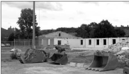
Erster Schritt ist dabei der Abriss des Kreisstraßenbauhofes, der sich zwischen Zauwiese und Veckenstedter Weg befindet. Die dort befindlichen Aufschüttungen, die u.a. aus Gießsand, Bauschutt und Hausmüll bestehen, erfordern eine umfangreiche und sachgerechte Sanierung der gesamten Fläche. Hierzu wird die vorhandene Oberfläche abgedich-
