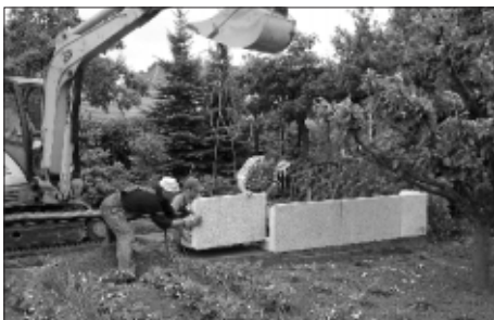
Baumaßnahmen auf der Zaunwiese
