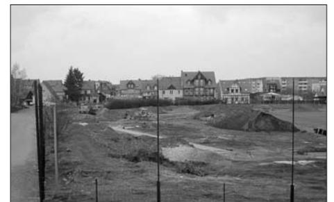
Die Bauarbeiten am Wernigeröder Sportforum laufen planmäßig entsprechend der Bauablaufplanung. Die Vorarbeiten zur Anlage der Laufbahnen sind nahezu abgeschlossen. Die Schichten des Untergrundes sind eingearbeitet, bei entsprechenden Temperaturen kann der Kunstbelag aufgebracht werden. Auch auf dem Spielfeld ist die Drainage verlegt und der Naturrasen bereits angesät.
