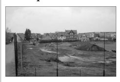
Die Bauarbeiten am Wernigeröder Sportforum laufen planmäßig entsprechend der Bauablaufplanung. Die Vorarbeiten zur Anlage der Laufbahnen sind nahezu abgeschlossen. Die Schichten des Untergrundes sind eingearbeitet, bei entsprechenden Temperaturen kann der Kunstbelag aufgebracht werden. Auch auf dem Spielfeld ist die Drainage verlegt und der Naturrasen bereits angesät.
