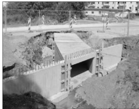
Ein Hauptproblem in diesem Straßenabschnitt besteht in der Erneuerung des Durchlasses für den Barrenbach. Die technologischen Abläufe wurden so festgelegt, dass über die gesamte Zeit der Bauarbeiten auch hier keine Vollsperrung notwendig wird, lediglich zum Aufbringen der oberflächlichen Deckschicht wird abschließend die Straße für 2 Tage voll gesperrt werden müssen. Gemäß dem vorliegenden Bauablaufplan ist die Fertigstellung der gesamten Bauarbeiten für den 31. August 2005 vorgesehen.
