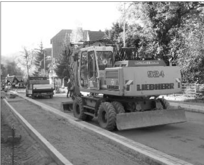
Die Arbeiten in der Salzberg- und Forckestraße machen gute Fortschritte. Nachdem alle Versorgungsleitungen und Kanäle verlegt wurden, konzentrieren sich die Arbeiten jetzt auf den Straßenbau. Mit der Fertigstellung von Borden und Gossen werden die Voraussetzungen für einen hoffentlich zügigen Asphaltbau geschaffen.
