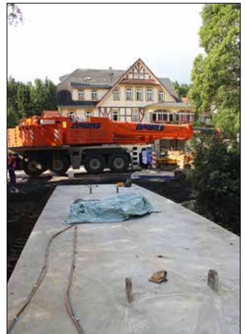
Die Betonplatte der kleinen Fußgängerbrücke ist aus einem Stück gegossen und wiegt 50 Tonnen. Die Brücke wird direkt beim Hotel »Bodeblick« über die Bode führen.
