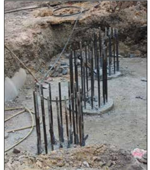
Die Gründungsbohrungen für die Fußgängerbrücke am Parkhaus sind abgeschlossen. Durch den torfigen Boden gehen die Bahrpfähle bis zu 14 Meter Tiefe.
