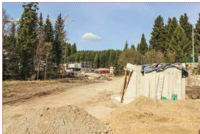
Hier wird die Fußgängerbrücke später die Ortsmitte mit dem Parkhaus verbinden. Anfang Juni wird die ca. 100 m lange Brücke in vier Segmenten geliefert und montiert.
