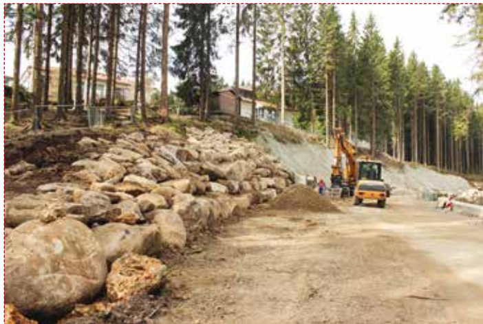
Auf weiten Teilen ist die spätere Straßenführung schon erkennbar. Im Bereich der Schierker Baude wird der Hang derzeit mit Granitblöcken verkleidet. Auf diese Weise kann das Straßenbild ursprünglich gehalten werden.
