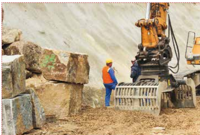
Ein einzelner Granitblock kann zwischen ein und zwei Tonnen wiegen. Für die Platzierung der gewaltigen Steine ist beim Baggerfahrer Fingerspitzengefühl gefragt.
