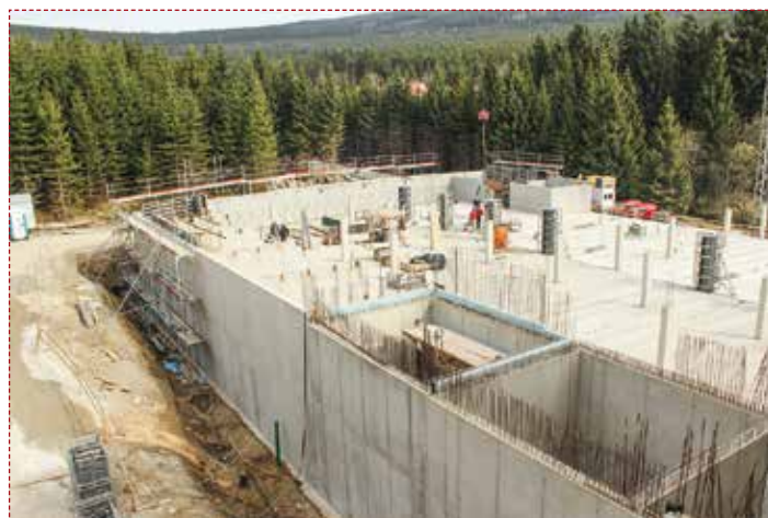
Für Ende April ist die Fertigstellung der letzten Decke geplant. Dann ist der auf dem Bild gezeigte Blick nicht mehr möglich. Hier wird später die Plaza sein und die Fußgängerbrücke ankommen.
