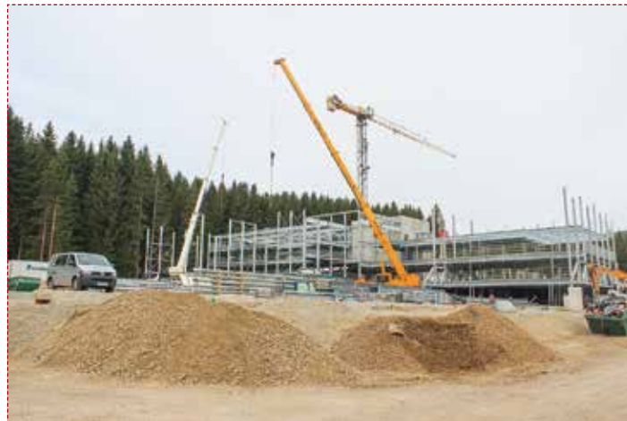
Das Schierker Parkhaus nimmt sichtlich Gestalt an. Die Fundamente sind fertig gestellt und die Stahlbaumontage hat Mitte März begonnen.
