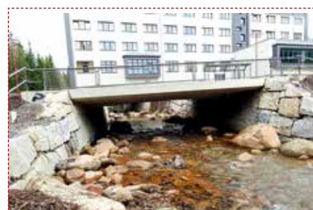
Brockenstraße, Neubau Brücke S4
