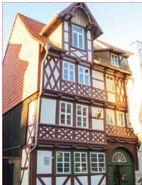
Breite Str. 95, Krellsche Schmiede, Sanierung
