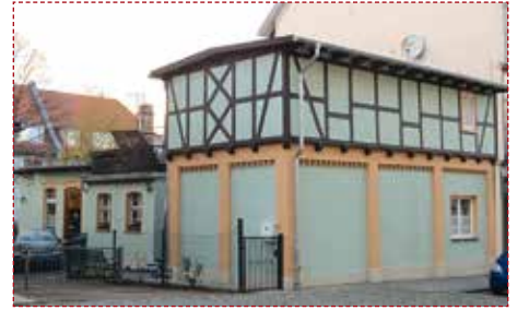
Albert-Bartels-Straße 11a, Sanierung
