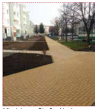
Minslebener Straße, Neubau Gehweg
