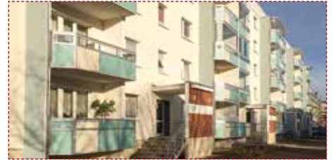
Minslebener Straße 57-71, WWG eG, Sanierung
