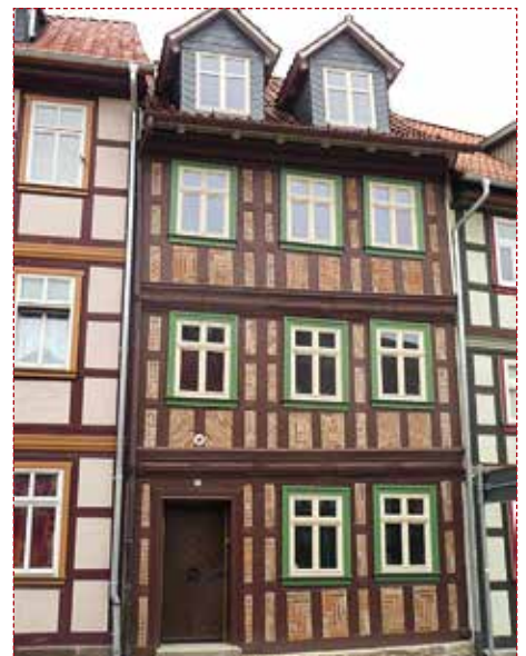
Schöne Ecke 38, Sanierung
