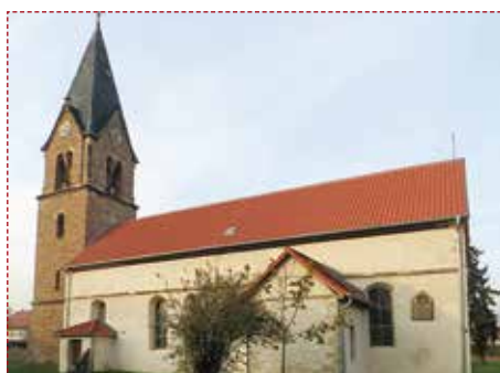
Reddeber, Sanierung Kirchendach und Turm
