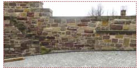
Schloss, Pflaster- und Entwässerungsarbeiten Trockenplatz
