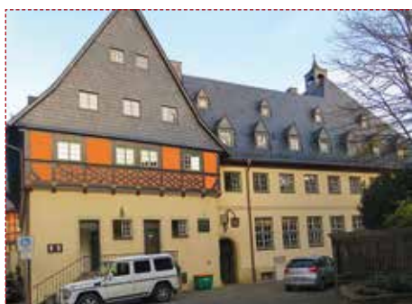
Rathaus, Sanierung Südwestgiebel
