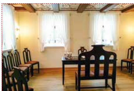
Rathaus Hochzeitserker, Sanierung
