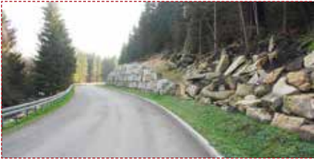
Schierke, Am Winterbergtor, Straßenbau
