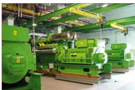
Am Kupferhammer, Sanierung Blockheizkraftwerk
