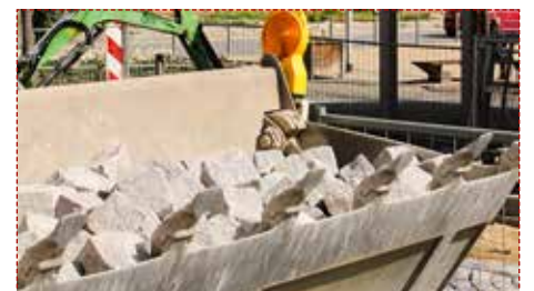
Eine frische Baggerladung Grauwackesteine für den Nicolaiplatz.
