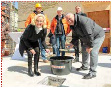
Unter den Augen der beteiligten Baufirmen und Oberbürgermeister Peter Gaffert (hinten rechts) legten Barbara und Dietmar Hanisch den Grundsteinlegung ihres neuen Intersport Hanisch Geschäftes in der Breiten Straße.
