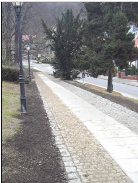
Hier wurden Betonbaustellenplatten, die als Wegebefestigung dienten, entfernt und durch Natursteinplatten und Natursteinpflasterung ersetzt. Die ebenen Natursteinplatten bilden die Zufahrtsfläche für Rollstuhlfahrer und Kinderwagen zum Lustgarten.
