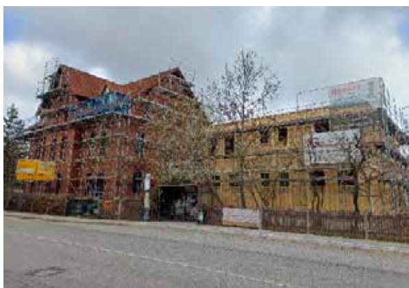
Abbildung 2: Wohnheim „Plemnitzstift“ - Neubau
