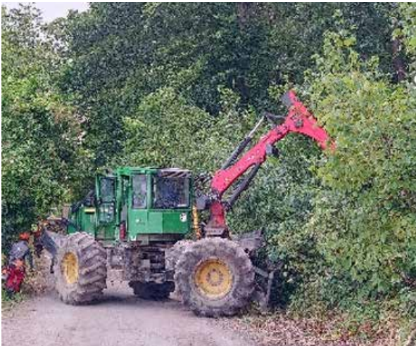
Verkehrssicherung Baumfällung am Maerkerstieg
