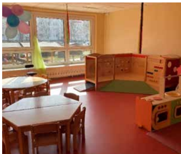
4. Bauabschnitt im Stadtfeld: Sanierung des EG der Kita „Pustebblume“
