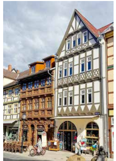
Wernigerodes Fachwerk-Juwelen in Breiten Straße 70 und 72 nach der GWW-Sanierung
