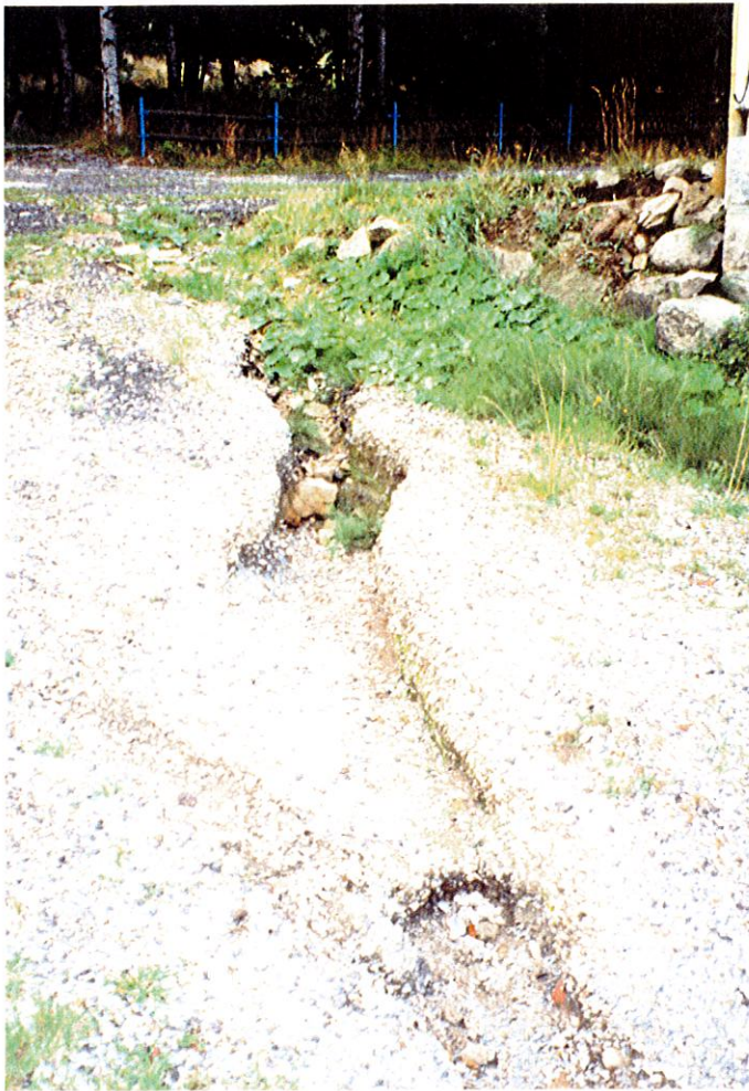
9 Quelliger Bereich an der nordwestlichen Grundstücksgrenze, unterhalb der Alten Wernigeröder Straße
