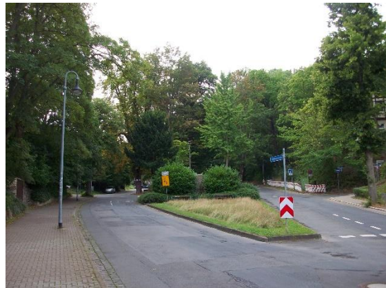
Defizite Salzbergstraße, Übergang Winde
