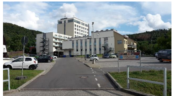
Überdimensionierung und fehlende Begrünung
