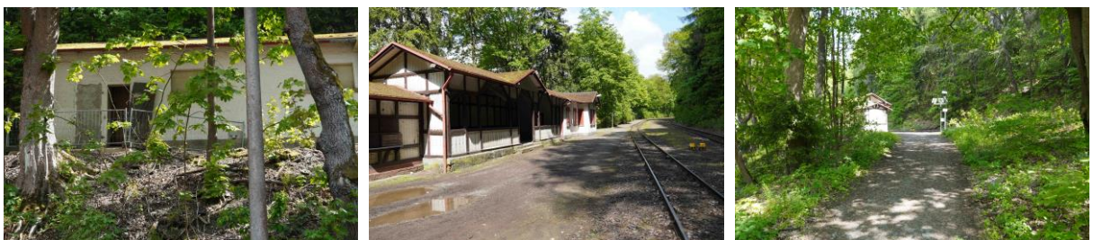
Dringender Aufwertungsbedarf am Bahnhofsgebäude sowie im Umfeld und im Bereich der Erschließung
