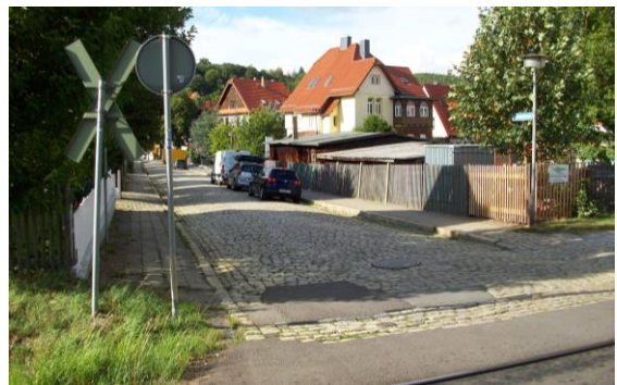
Defizite Übergang und Zustand Frankenfeldstraße
