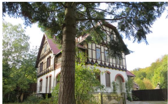
Forsthaus nach Sanierung zur Kita (Quelle: Stadt Wernigerode)
