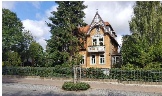
Friedrichstraße, Kita Villa Sonnenschein
