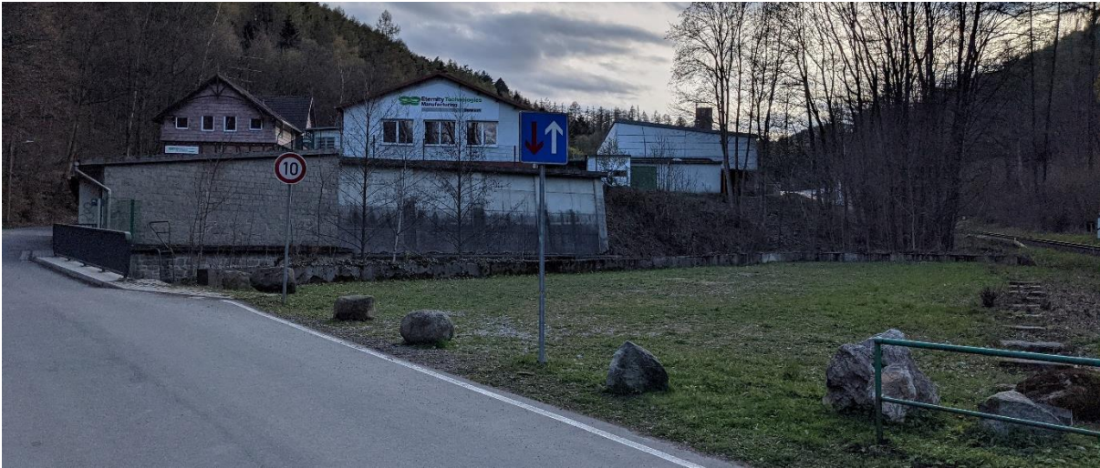
Gewerbestandort, Zufahrt von östlicher Seite*
