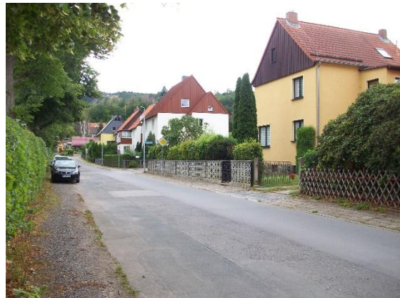
Defizite Randbereich, Mannsbergstraße
