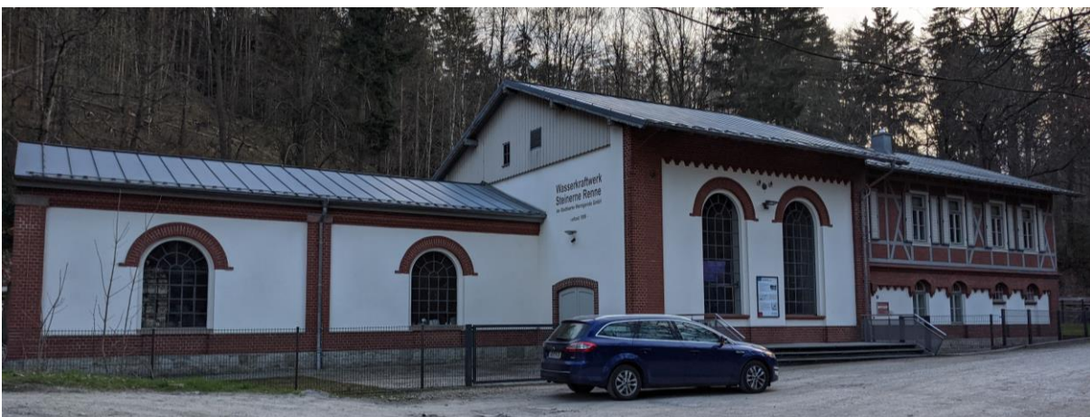
Denkmalgeschütztes Wasserkraftwerk Steinerne Renne*
