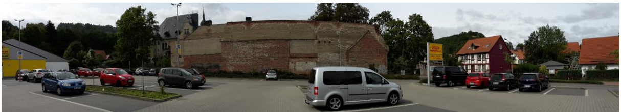
fehlendes Großgrün zur Verschattung und Raumkantenbildung zur Straße, starke Versiegelung
