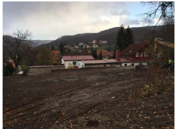
Freigelegte Bereiche des Plangebietes, Blick nach Südosten
