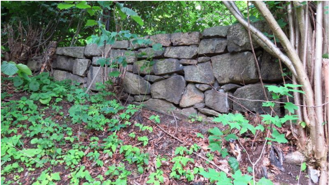
Abbildung 5: Bruchsteinmauer in Nabsicht – Stand 30.06.2017.
