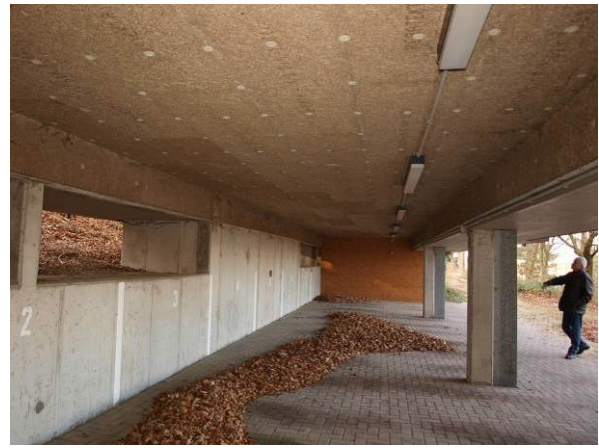
Tiefgarage ohne Befunde
