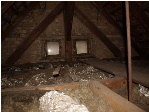
Dachboden ohne Befunde
