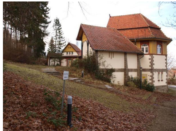
Einzelner Baukörper von 1905, ohne Gebäudebrüter
