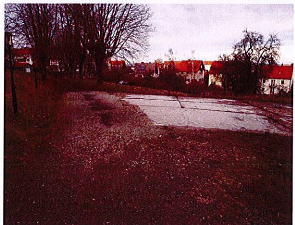
Zufahrt, Kastanienallee und Betonfläche unterhalb des ehem. „Berghotels“
