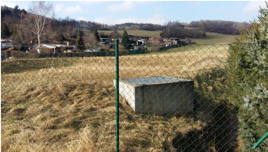
Abbildung 22: Regenrückhaltebecken am Conventbach (Quelle: Steinbacher-Consult, März 2018).
