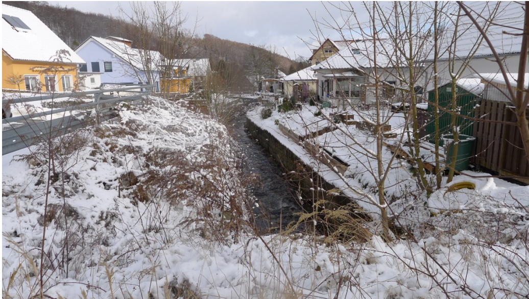
Abbildung 10: Öffnung der Verrohrung durch Eigenheimsiedlung am Braunen Wasser (Quelle: Steinbacher-Consult, Januar 2018).
