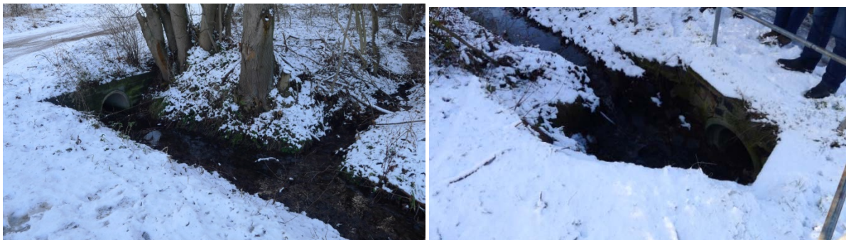
Abbildung 18: Beispielhafte Durchlässe am Schmuckgraben (Quelle: Steinbacher-Consult, Januar 2018).
