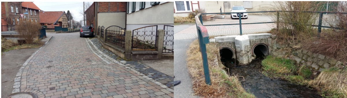
Abbildung 26: : Hellbach in Benzingerode neben Wasserstraße und Einlaufbereich Doppeldurchlass (Quelle: Steinbacher-Consult, März 2018).
