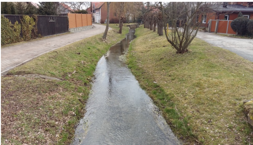
Abbildung 25: Verlauf des Barrenbachs nördlich der Straße Am Wasser in Minsleben (Quelle: Steinbacher-Consult, März 2018).
