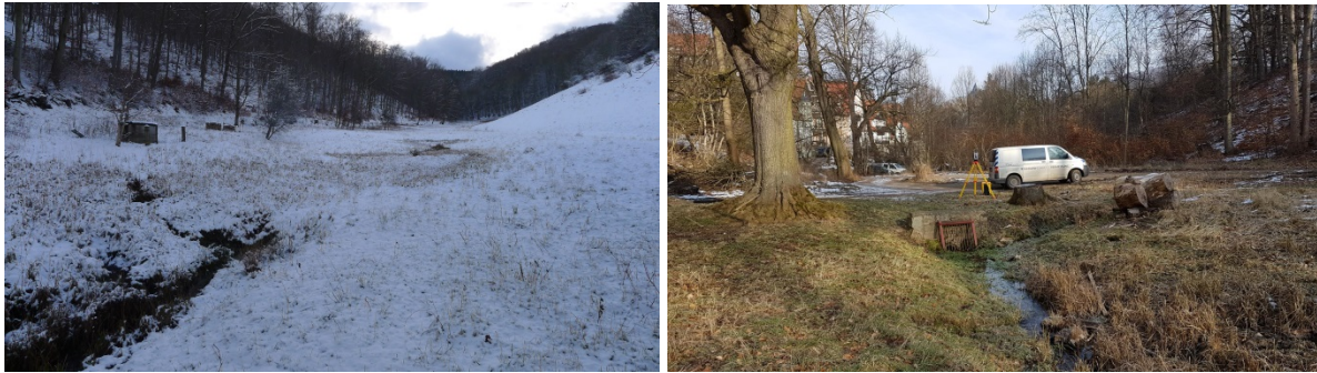
Abbildung 14: Quellgebiet des Bollhasentals (links) und Beginn der Verrohrung (rechts) im Bollhasental; (Quelle: Steinbacher-Consult, Januar und Februar 2018)
