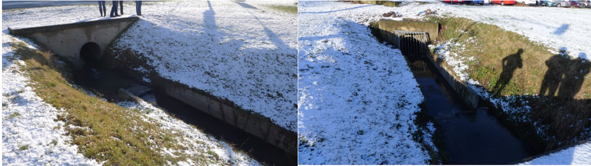
Abbildung 20: Schmuckgraben wird zum Kohlgartengraben (Quelle: Steinbacher-Consult, Januar 2018).
