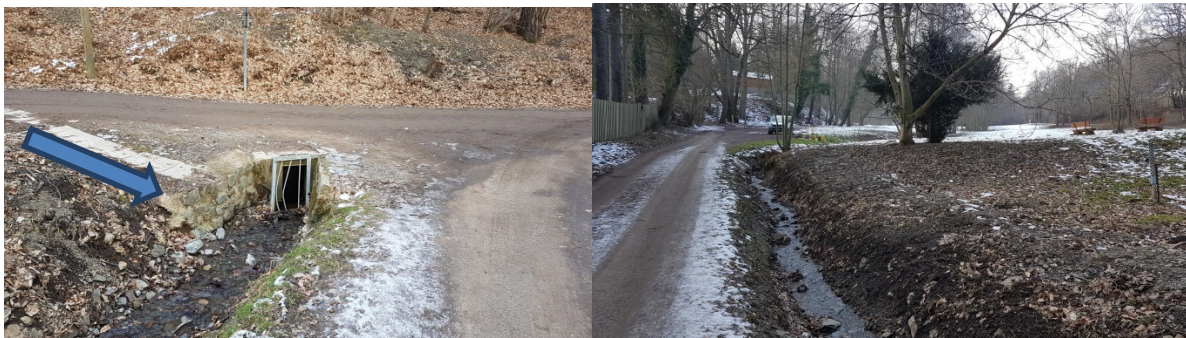
Abbildung 12: Himmelpforte mit Standort für einen möglichen Rechen / Aufschiebegitter; (Quelle: Steinbacher-Consult, Februar 2018)
