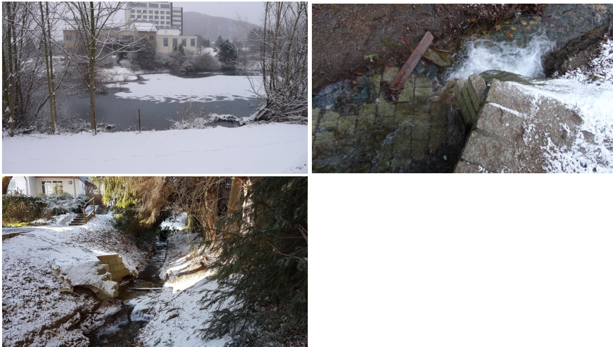
Abbildung 4: Sturzbach; Fischteich beim Hasseröder Burghotel und Verteilerbauwerk am Sturzbach (Quelle: Steinbacher-Consult, Januar 2018).
