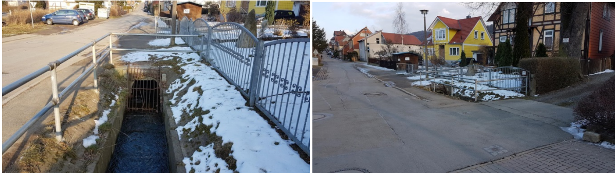
Abbildung 3: Sturzbach; Durchlass im Bereich des Bahnübergangs (Quelle: Steinbacher-Consult, Januar 2018).
