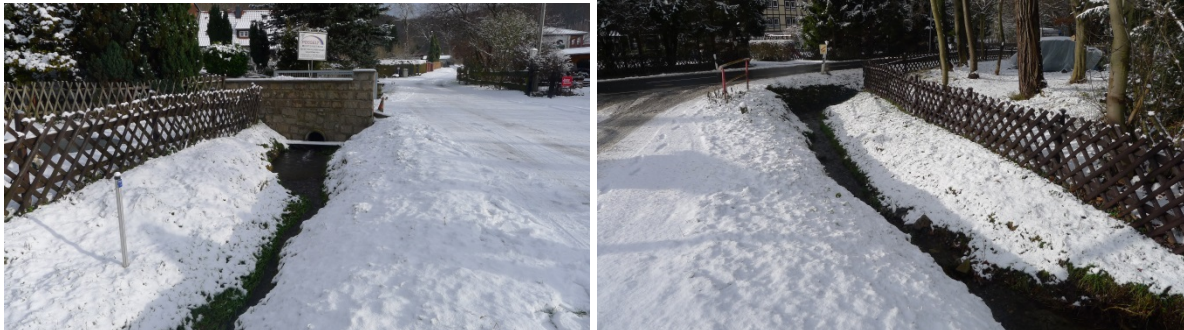
Abbildung 16: Friederickentalbach wird durch Verrohrungen unter zahlreichen Ausfahrten hindurchgeführt (Quelle: Steinbacher-Consult, Januar 2018).
