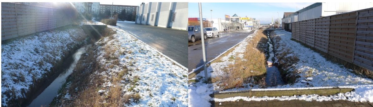
Abbildung 21: Kohlgartengraben in Richtung Silstedter Bach (Quelle: Steinbacher-Consult, Januar 2018).
