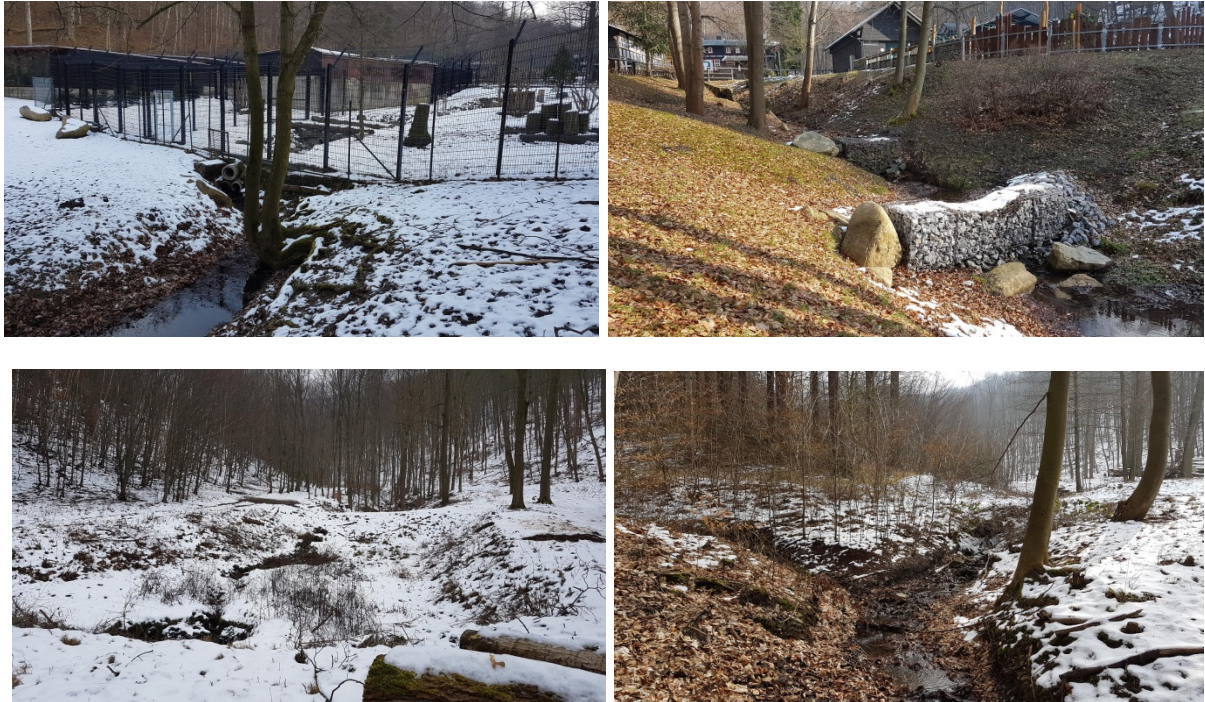
Abbildung 15: Christianental mit zahlreichen Verrohrungen und Durchlässen (oben); Luisentalteiche (unten links); Zusammenfluss von Christianen- und Luisental (unten rechts) (Quelle: Steinbacher-Consult, Februar 2018).
