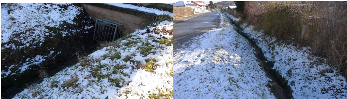
Abbildung 19: Situation am Schmuckgraben (Quelle: Steinbacher-Consult, Januar 2018).
