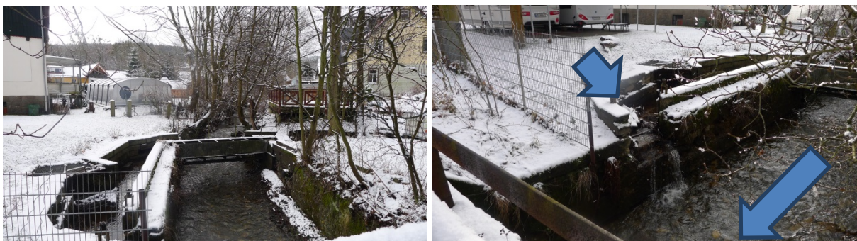
Abbildung 11: Verbindungsbereich von Mülhgraben und Braunem Wasser; „Wasserschloss“; (Quelle: Steinbacher-Consult, Januar 2018).
