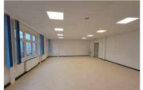
Heidebreite 10, GS Harzblick, etagenweise Innensanierung
