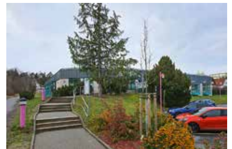
Weinbergstraße 1, Schwimmhalle, Sanierung Haustechnik
