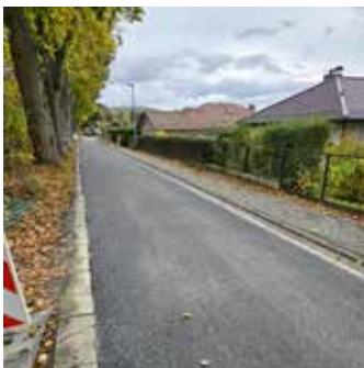
Eisenberg, Trinkwasser, Restbreitensanierung Stadt WR mit Stadtwerken
