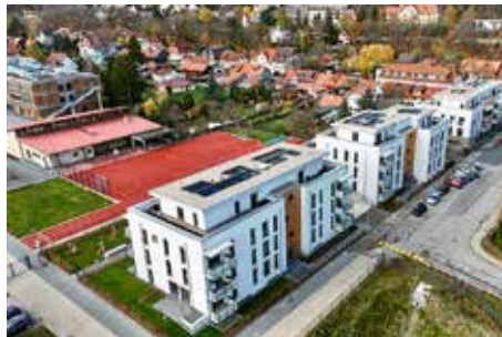
Lutherstraße 2, 4, 6, Neubau Wohn- und Geschäftshäuser – GWW, Bordanlage und Gehweg
