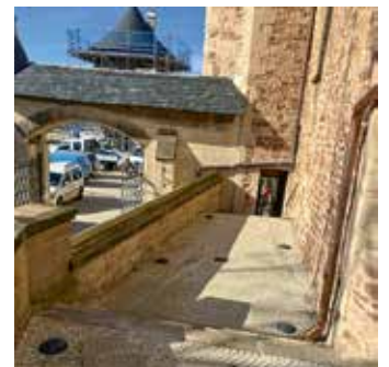
Schloss, Apfelbaumterrasse, Sanierung
