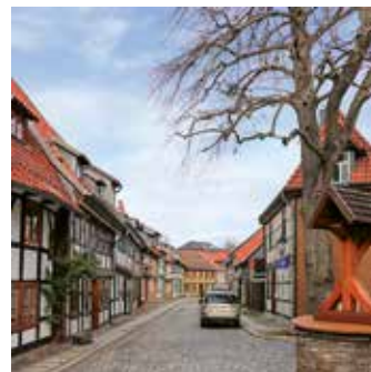
Hinterstraße, Ausbau mit Fernwärme, Strom und Erdgas – Stadtwerke WR
