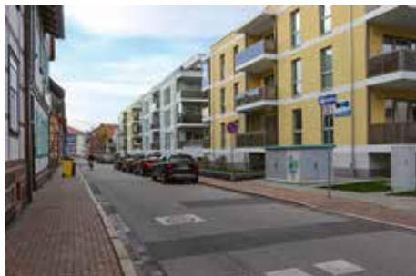
Georgiistraße, Fernwärmeverlegung – Stadtwerke und Fertigstellung der Wohngebäude – WWG
