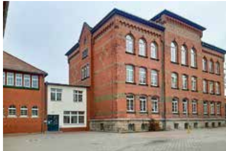
Gustav-Petri-Straße 3, GS Diesterweg, Fensterreparatur, Türerneuerungen, Sporthallengiebel Innenwärmedämmung
