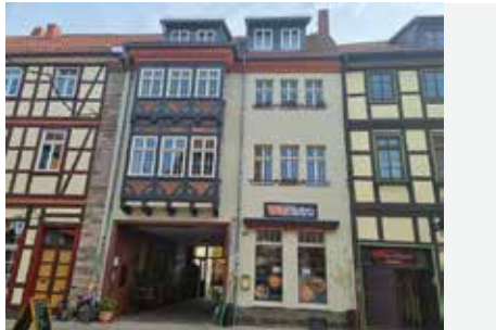
Breite Str. 88, Fassadensanierung
