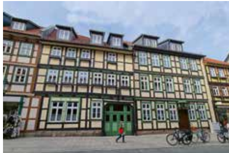
Breite Str. 57, 59, Tor- und Fassadensanierung
