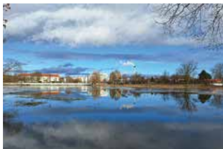
Veckenstedter Weg, Kurtsteich, Grundleitungs- und Mönchsreparatur, Schilfmähd mit Ausbau des Geh- und Radweges am Barrenbach
