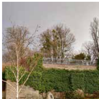
Lindenallee, Mauer am Lustgarten, Mauer- und Zaunsanierung
