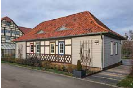
Kurtsstraße 11, Schäferhaus Bürgerpark, Fassadensanierung – Stadt WR
