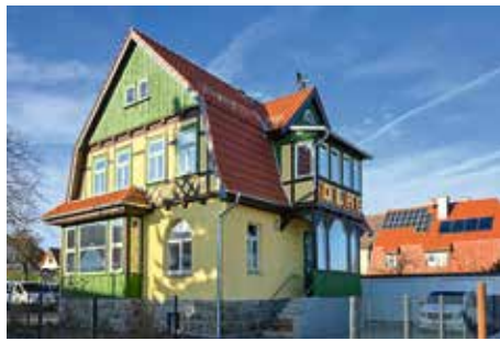
Weinbergstraße 2, Fassadensanierung DLRG
