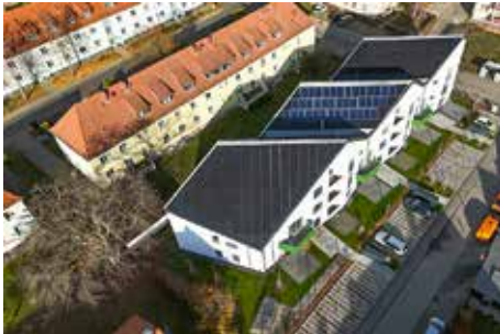
Pappelweg 33, 34, 35, Neubau Sonnenhaus – GWW, Strom-, Trinkwasserleitung – Stadtwerke
