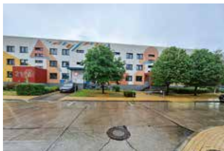
Walther-Grosse-Ring 21, Sanierung EG Pustelblume, Windfang-Unterfangung
