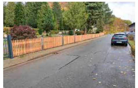
Am Eichberg 7, Zentralfriedhof, Zausanierung in Teilabschnitten
