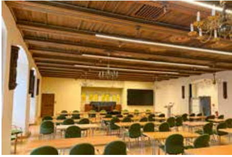
Marktplatz 1, Ratssaal, Sanierung und Modernisierung – Stadt WR
