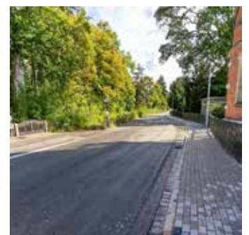
Burmühlenstraße, grundhafter Ausbau mit Medien und Gehweg – Stadtwerke WR
