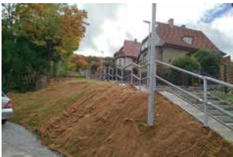
Sanierung der Treppenanlage Blockshornbergsweg – Stadtwerke WR
