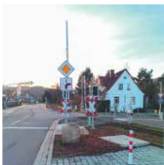
Ausbau Triangel, HSB Schrankenanlage, Frankenfildstraße, Hochwasserschutz Sturzbach
