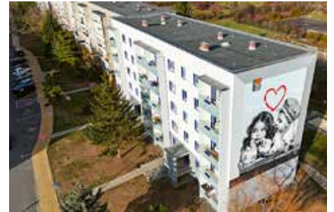
Elise-Crola-Straße 2, 4, Sanierung – GWW
