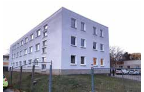
Kohlgartenstraße 2, Haus der Vereine, Sanierung innen und außen
