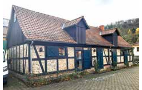
Christianental 11, Wirtschaftshof, Fassadensanierung
