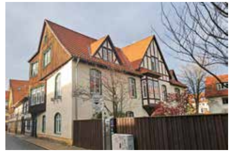
Steingrube 8, Senioren- und Familienhaus, Fenstererneuerung
