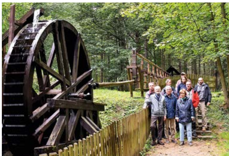
Wasserkunst bei Wiederinbetriebnahme nach Generalreparatur
