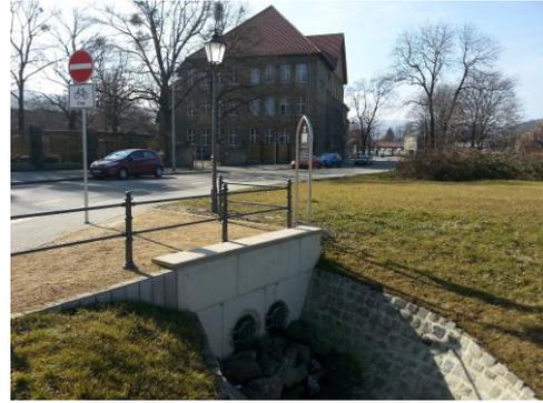
**Auslaufbereich des Mühlengraben** ausgebaut und aufgewertet. Der Auslauf des Mühlengraben wurde mit einer Stützmauer und einem Geländer versehen. Auf dem davor liegenden Platz befindet sich eine Informationstafel über die Historie des Mühlengraben, sowie eine Altstadtleuchte die in der Baumaßnahme Unter den Zindeln ausgebaut und Instandgesetzt wurde.
