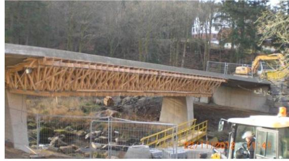
In Oberschierke wurde eine Brücke als Ersatzneubau an der Jugendherberge errichtet. Diese Einfeldbrücke nimmt den Fußgänger- und den Fahrverkehr auf. Die Anbindung erfolgte an der Brockenstraße und zum Sandbrink. Zur Verbesserung der Infrastruktur wurde eine Bushaltestelle mit errichtet. Diese kann erst nach Fertigstellung des Straßenzuges am Sandbrink ihrer Funktion zugeführt werden. Bauzeit von April 2012 bis November 2012.
